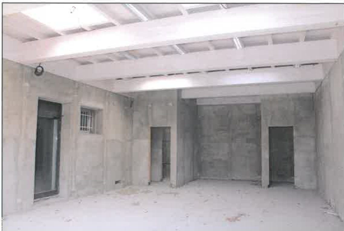
INTERNI: ZONA 2 – LOCALI TECNICI (Fabbricato “A”)
