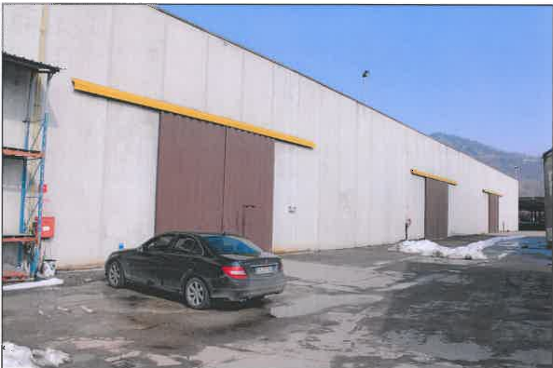
PROSPETTO SUD (Fabbricato "B") - MAGAZZINO
